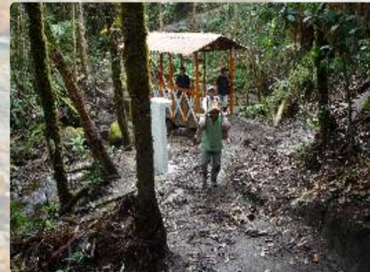
Puente Peatonal "El Páramo" - SNTN
