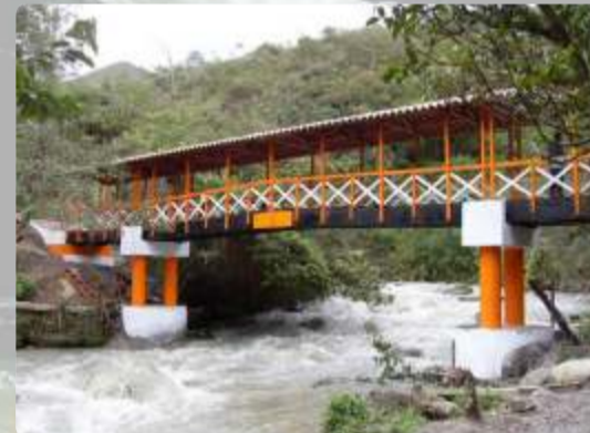
Puente Peatonal "El Cañaveral" - Tabaconas
