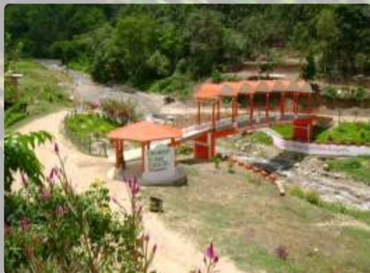
Puente Peatonal Auxiliar "El Romerillo" - 09 de Octubre, San Ignacio
