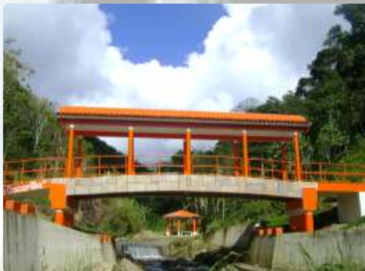
Puente Peatonal Auxiliar "La Cascarilla" - 09 de octubre, San Ignacio
