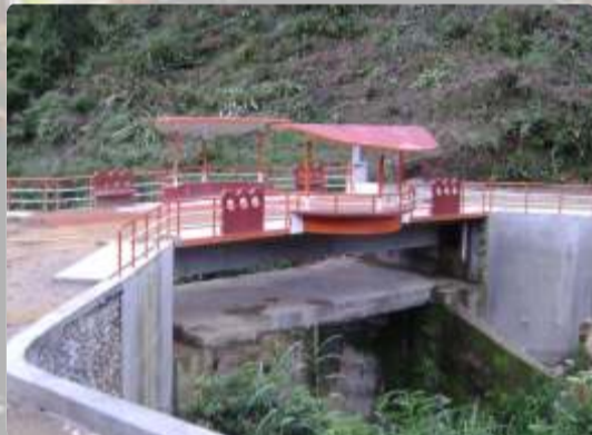
Puente Vehicular "Ananuaya" - Tabaconas
